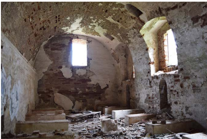
Interiér nového ležáckého sklepa za sýpkou, 2022. Ve stěnách a v klenbě jsou otvory větracího a chladicího systému. (foto: P. Borský)
