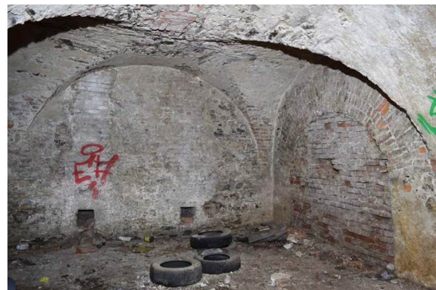
Klenutý sklep pod sýpkou s dodatečně proraženým otvorem větráku ve vrcholu klenby (otvor byl znovu zazděný), 2022. (foto: P. Borský)
