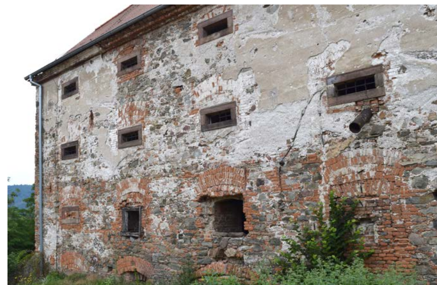
Zadní průčelí sýpky, 2022. Mezi okny 2. a 3. patra jsou fragmenty malovaného pásu, který byl součástí iluzivního členění fasád. (foto: P. Borský)
