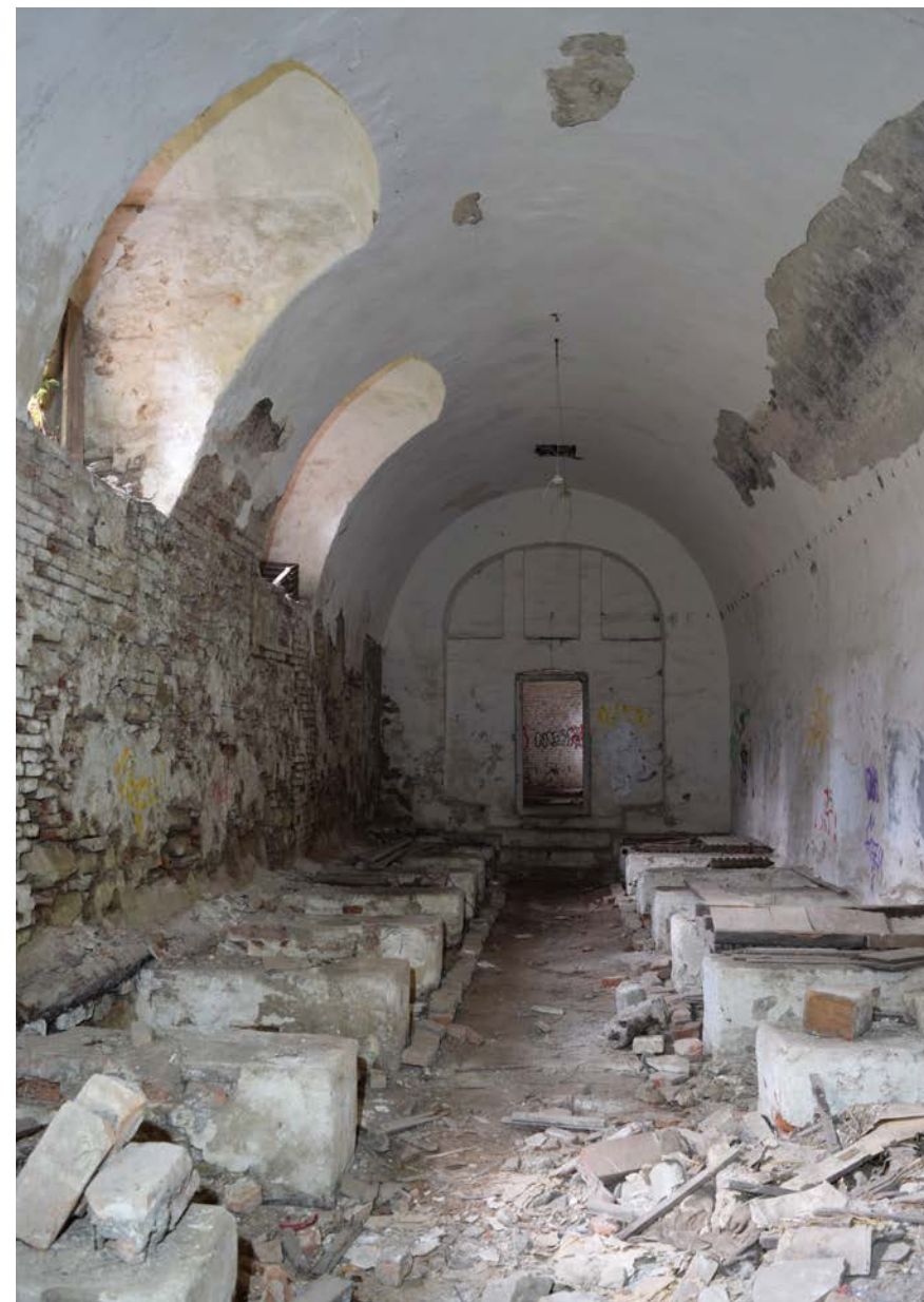
Starý pivovarský sklep v přízemí sýpky, který J. Rosenberg upravil a začlenil do nového chladného hospodářství pivovaru, 2022. (foto: P. Borský)
