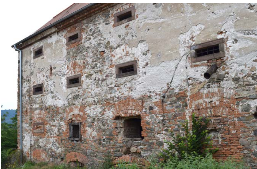
Zadní průčelí sýpky, 2022. Mezi okny 2. a 3. patra jsou fragmenty malovaného pásu, který byl součástí iluzivního členění fasád. (foto: P. Borský)
