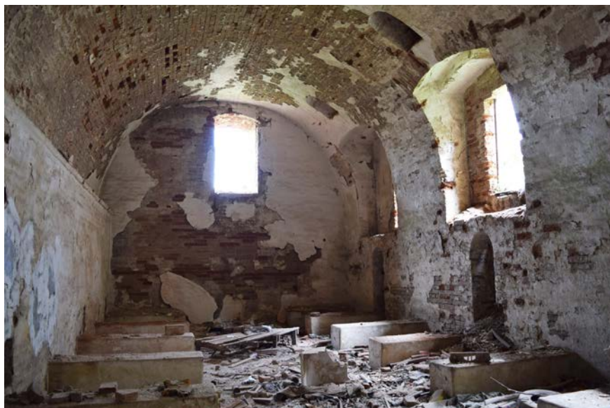
Interiér nového ležáckého sklepa za sýpkou, 2022. Ve stěnách a v klenbě jsou otvory větracího a chladičho systému. (foto: P. Borský)
